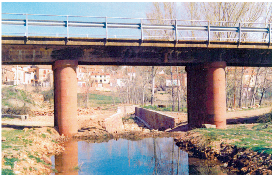
Embocadura de la canalización. Foto J. Sánchez. 1999.
